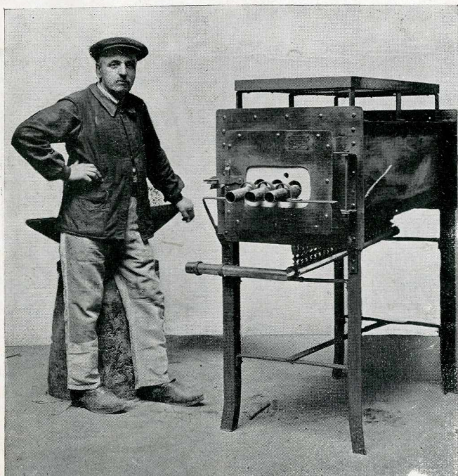
Fig. 53. — Four Incliné à tubes
